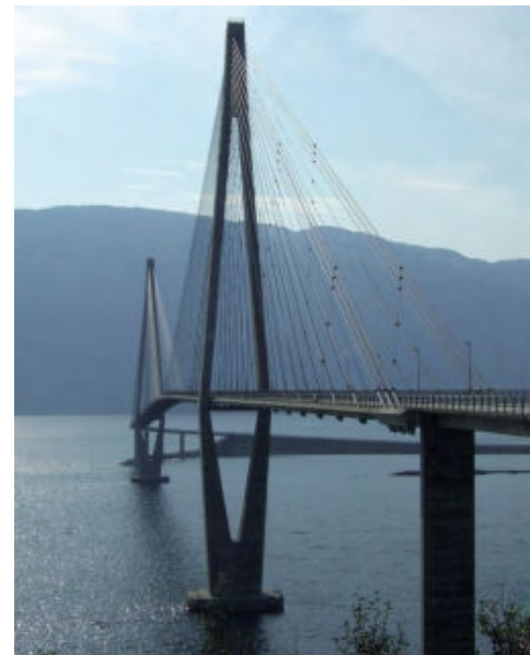
Helgelandsbrua er et eksempel på brobyggerkunst som ikke ville vært mulig uten bruk av moderne, armert betong. Ved hjelp av armering klarer denne betongkonstruksjonen å ta opp store strekkrefter, og man kan lage en slank konstruksjon med redusert materialbehov. Brua har i alt 12 spenn hvorav hovedspennet er på 425 meter, og seilingshøyden er 45 meter. Alle pilarene er bygd med klatreforskaling, også de to hovedtårnene som bærer «fritt frambygg»-delen. Brubanen er betydelig slank i horisontalplanet, bare 40 cm i tykkelse på midten og 1,2 meter i ytterkant. Hovedtårnene er 138 og 127 meter høye fra havoverflaten og til toppen. I tillegg er det nordligste tårnet fundamentert ned til en dybde på 30 meter under havoverflaten. Tårnene er 6 meter brede sett fra siden av brua og 2,2 meter på det smaleste, sett på tvers av brua. Brua ble konstruert av Elljarn Asbjørn Jordet i Aas-Jakobsen AS i samarbeid med det tyske konsulentfirmaet Leonard, Andrae und Partner. Kilde: Wikipedia Foto: Wikimedia Commons
